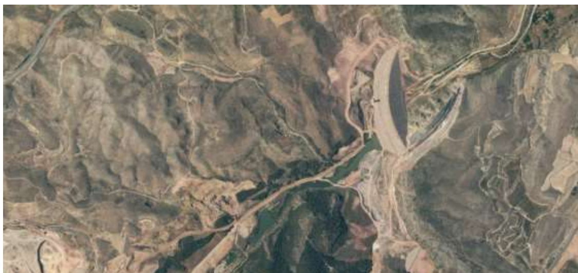
Ortofotografía de la construcción del embalse de Mularroya. Fuente Iberpix.
